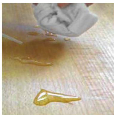
Wasser an schadhafter Stelle einwirken lassen
